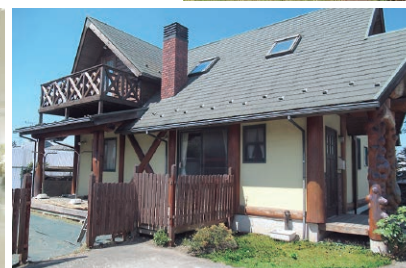
デイケアセンター 木のぬくもりが溢れ、暖炉のある建物で一部プログラムを行います。
